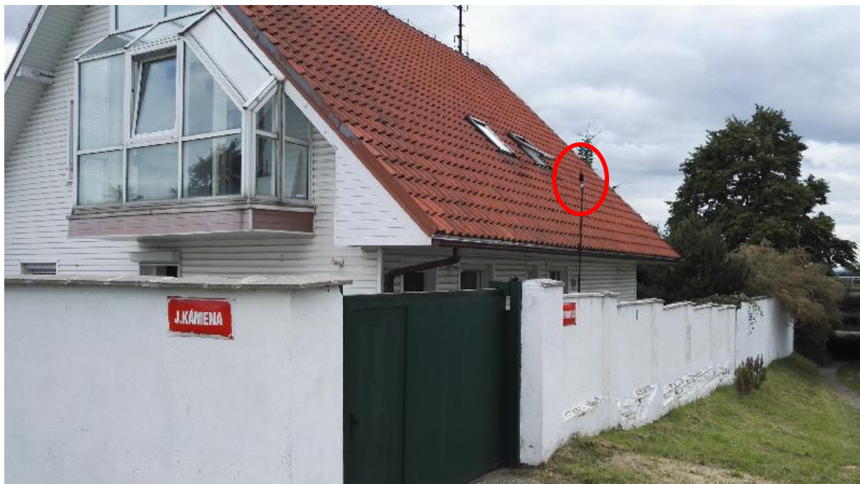
měřicí bod č. 1 - 2 m před severní fasádou v úrovni 2.NP, RD J. Kámena 93, Zdiby
