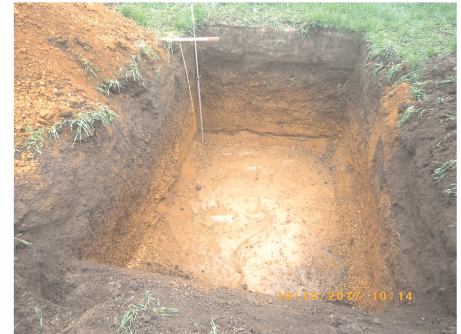
Foto 3. Kopaná sonda KS1 po úplném zasáknutí 2500 l vody. Konec první velkoobjemové zasakovací zkoušky ze dne 19.10.2017.
