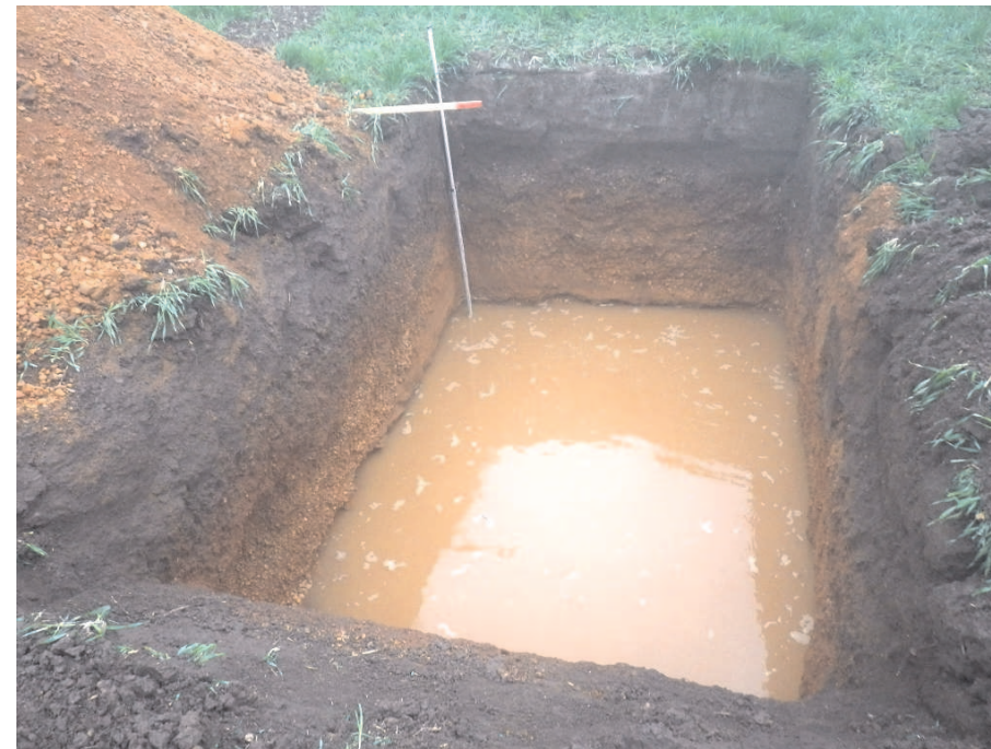
Foto 2. Kopaná sonda KS1 po napuštění 2500 l vody. První velkoobjemová zasakovací zkouška ze dne 19.10.2017.
