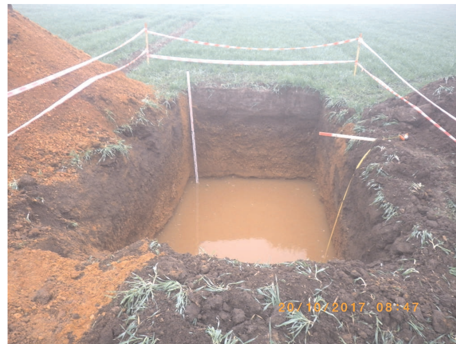
Foto 5. Kopaná sonda KS1 po napuštění 2500 l vody. Druhá velkoobjemová zasakovací zkouška ze dne 20.10.2017.
