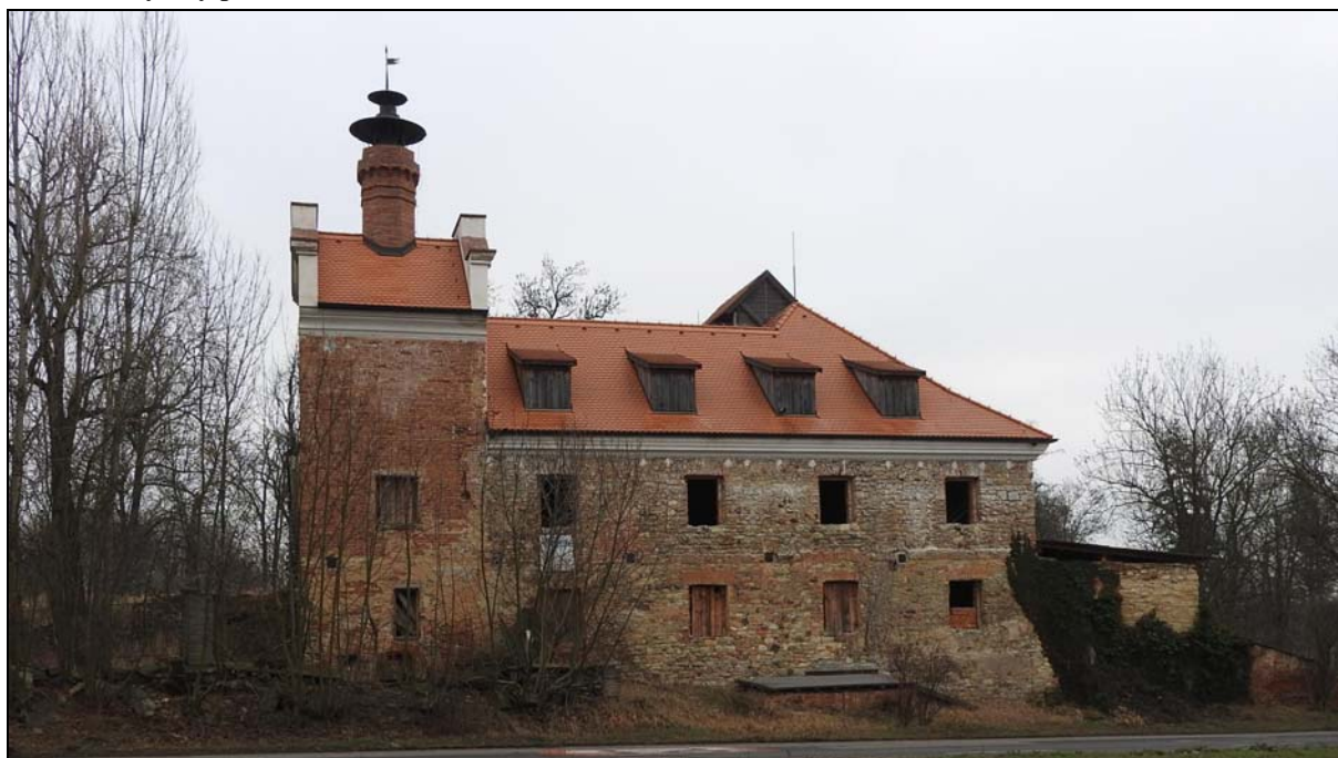
obr. č. 6: Bývalý pivovar v blízkosti zámku
