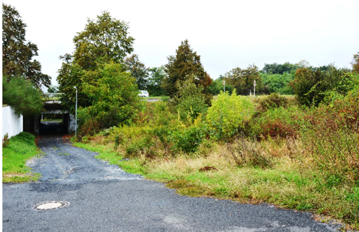
Foto úseku LBK 3 u podchodu přes silnici č. II/608
