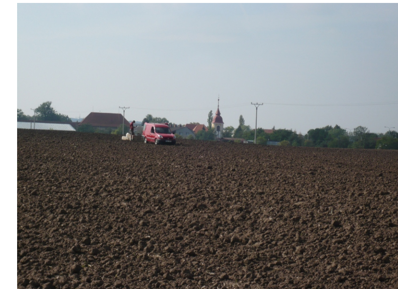
Foto č. 4. Realizace dynamické penetrace DP 27
